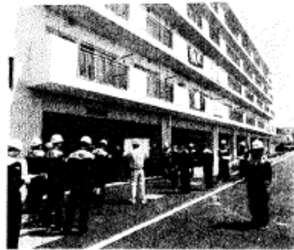
(北浜災害公営住宅)
