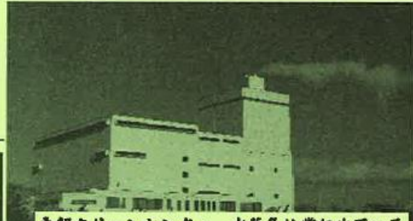
東部クリーンセンター、水蒸気は常に出ている
