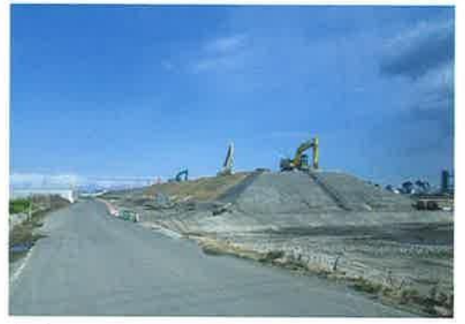
急ピッチで進む東部復興道路
