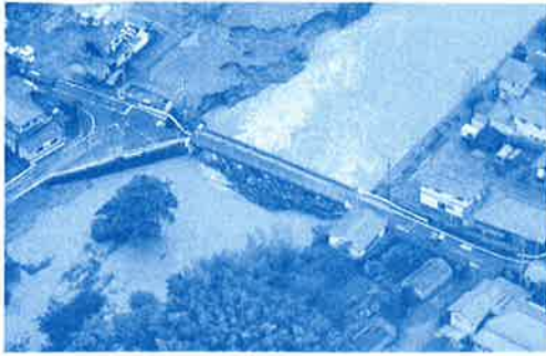
決壊した泉区根白石・馬橋付近(9/11)
