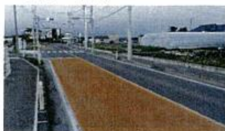
交差点部のカラー化による 交通安全対策(避難道路横断等)
