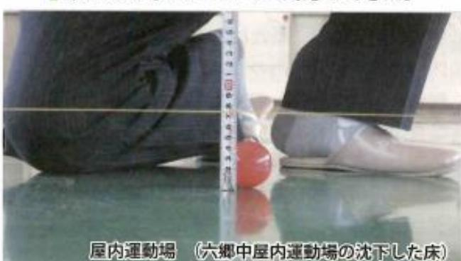
屋内運動場（六郷中屋内運動場の沈下した床）
