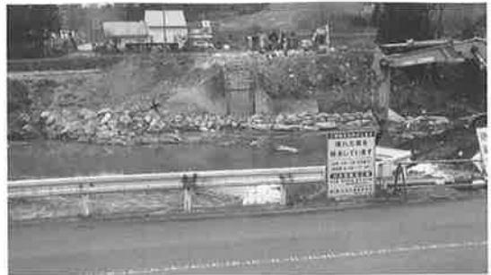
▲ 流失した川井橋の撤去が行われた両岸
