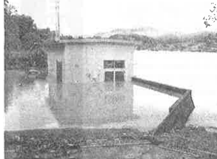
台風19号で水没した千咲原揚水機場
