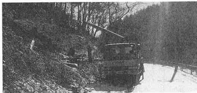
山橋地区を走る県道添いの杉の伐採が行われ、感謝です。
