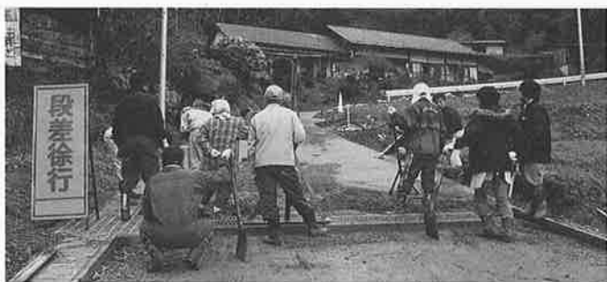
共同作業で、道路舗装を行う北山形地区の皆さん
