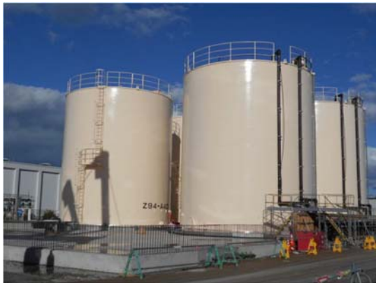
高性能多核種除去設備用サンプルタンク
