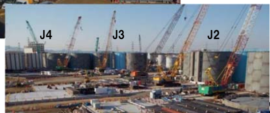
J2~J6エリア で増設中の 溶接タンク
